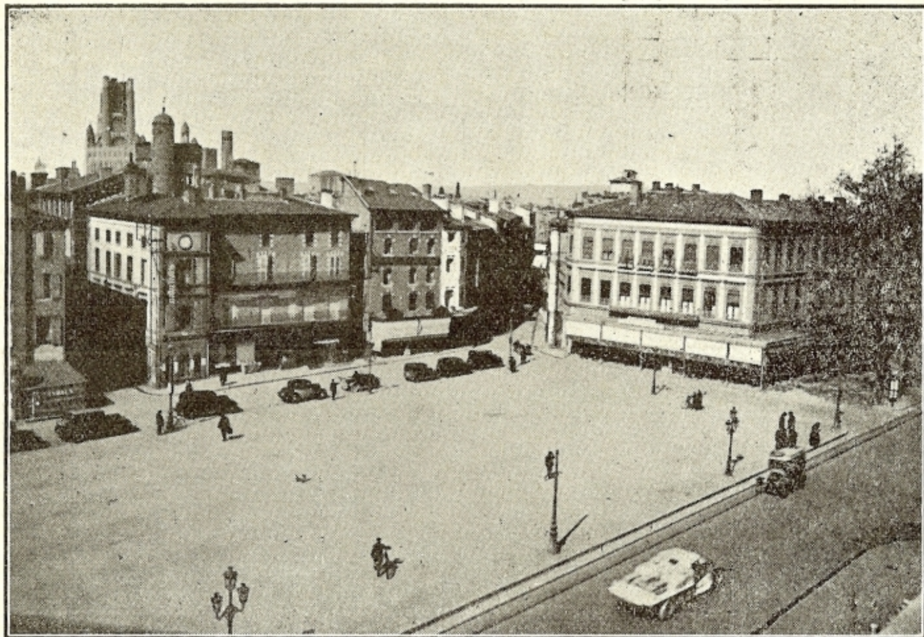
Place du Vigan. — Les grands cafés.
